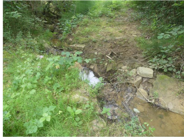
Ruisseau de Fourtanier - ouvrage hydraulique disloqué («Camp de la rivière»)
