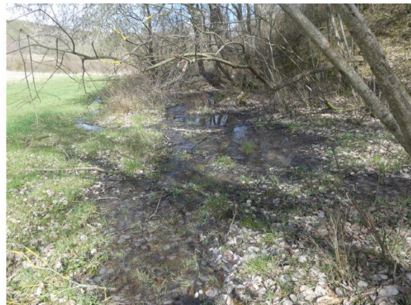
Ruisseau de la Coume Bugue - quasi comblement («Cazaillou»)
